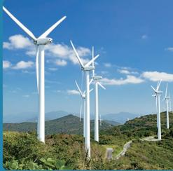
風の子カラで風車を回し、その回転運動を発電機に伝えて電気を起こします。陸上に設置されるものから洋上に設置されるものまであります。
