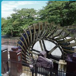
水力発電は河川などの高低差を活用して水を落下させ、その際のエネルギーで水車を回して発電します。現在では農業用水路や上水道施設などでも発電できる中小規模のタイプが利用されています。
